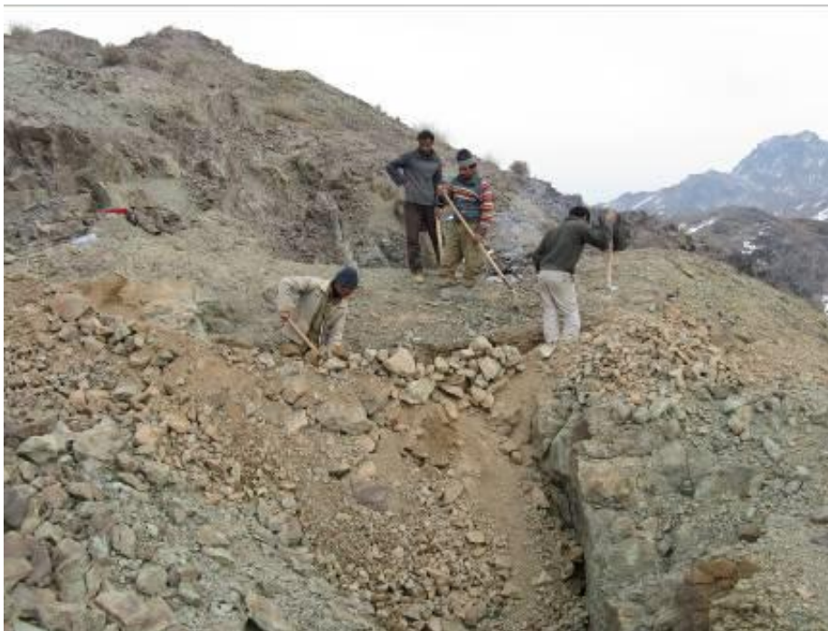
شکل ۷- ترانشه شماره ۱ منطقه مورد مطالعه
