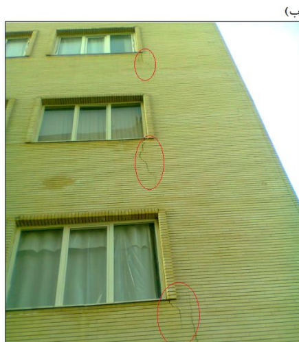
شکل ۴- نمونه‌هایی از مشکلات سازه‌های احداث شده بر روی لایه‌های رسی در شهر تبریز: الف) ناپایداری شیب نگین پارک ولیعصر (Sadrekarimi et al., 2006) ب) انحراف سازه‌ها در اثر نشست، کوی باغمیشه.
