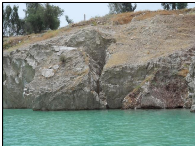
شکل ۱۴. لغزش دیواره مخزن
