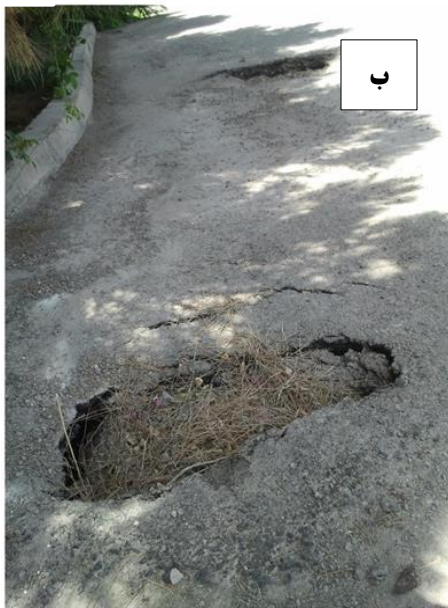
شکل ۲. میله قنات (شکل الف) و ریزش و نشست به خاطر وجود قنات در عمق (شکل ب) در منطقه مورد مطالعه.
