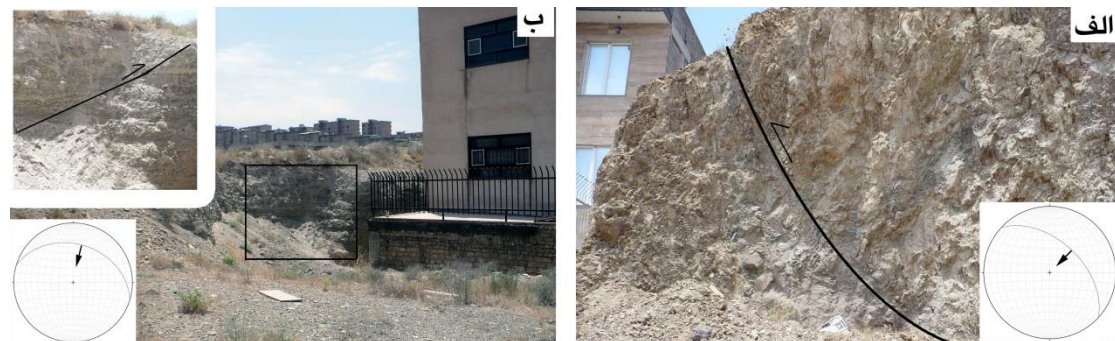
شکل ۱۳. شواهد گسلس راندگی پارک مشاهیر در نهشته‌های اتوسن (الف) و گسل جنوب پارک مشاهیر در نهشته‌های کواترنری (ب) در محدوده شهر پردیس که بدون توجه به رعایت حریم گسل ساخت و ساز در مجاورت آن انجام شده است. استریوگرام‌ها کینماتیک گسل‌ها را نشان می‌دهند. موقعیت تصاویر بر روی شکل (۳) نشان داده شده است.
