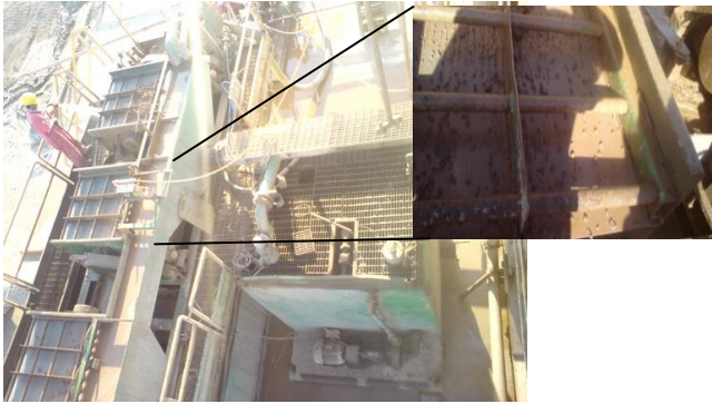
شکل ۲. نمایی از الکهای لرزان و خرده‌های خارج شده از چاه حفاری
